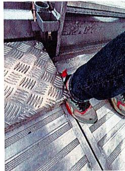
**Fotografía 21-22-23-24.** Otra de las posibles fallencias de las graderías se localiza en el costado de los pasos intermedios, ubicados en la gradería para normalizar la altura y conformar las escaleras, cuyos costados no cuentan con una tapa o elemento de cierre lateral.
