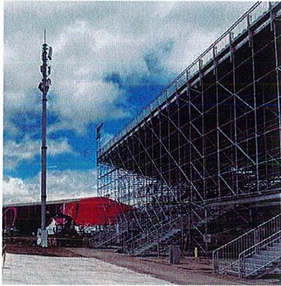
**Fotografía 27.** No se evidencia uniformidad en la colocación de diagonales, por lo cual se debe contar con los planos completamente referenciados a ejes, con alturas y dirección, niveles de instalación y demás información relevante, los cuales además deben estar asociados a las elevaciones o alzados resultantes del modelo matemático bajo el cual se determina su lugar de instalación en el sistema de gradería
